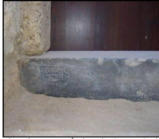
لوحة 7 – عتبة سفلى بازلت أسود بين مداميك مدخل الرباط
