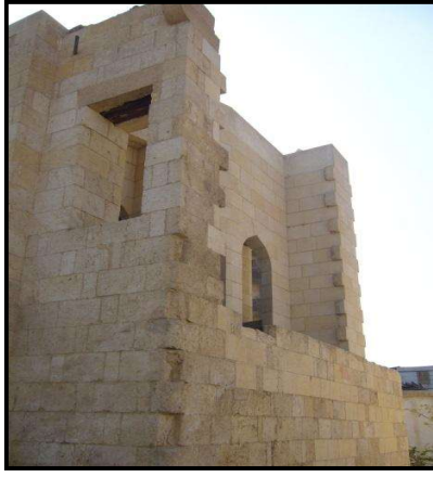
لوحة 8 – الركن الشرقى للواجهة الجنوبية الشرقية
