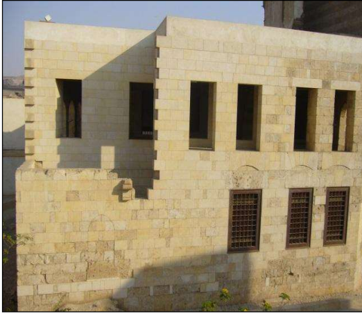
لوحة 14 - الواجهة الشمالية الشرقية
