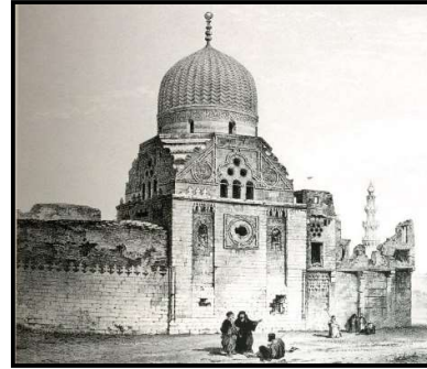
لوحة 9 – رسم بريس دافين لقبة طراباي والرباط من الجهة الجنوبية الشرقية توضح وجود بقايا طابق ثان بالرباط وكتلة بناء من الطوب أعلى المدخل الرئيسي الذي تم تسديده آنذاك
