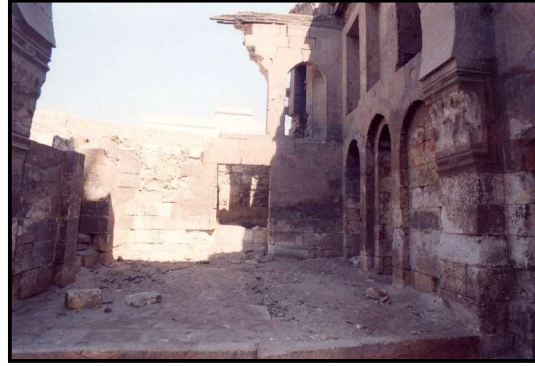
لوحة 19 - الإيوان الشمالي الشرقي للرباط قبل الترميم
