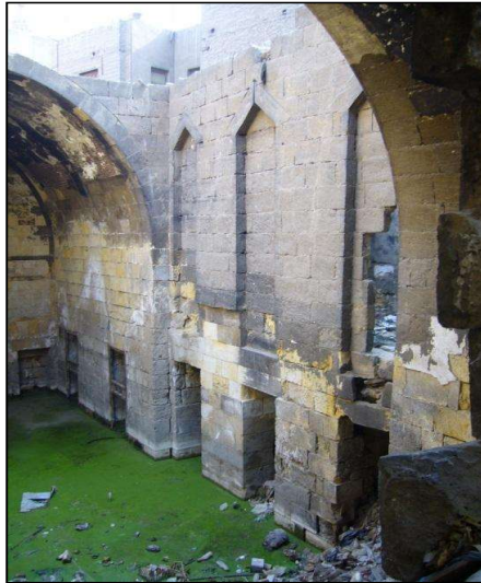
لوحة 37 - الجزء الجنوبي الغربي لرباط زوجة إينال
