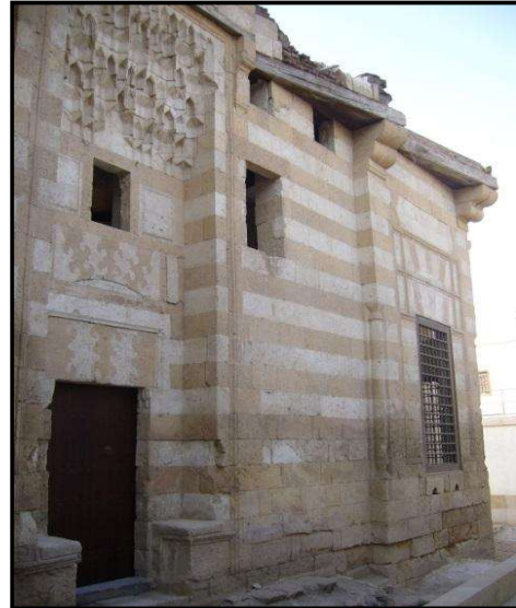
لوحة 5 - الواجهة الجنوبية الشرقية لرباط أزدمر - بعد الترميم
