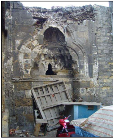
لوحة 35 - المدخل الرئيسي لرباط زوجة إينال- حالياً
