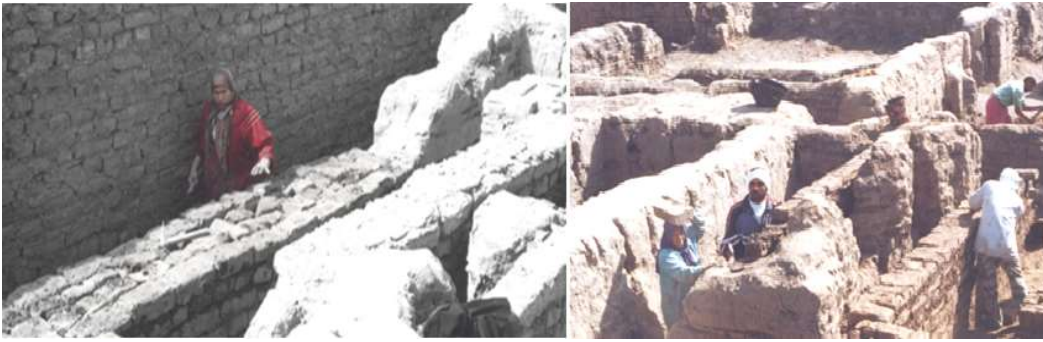
صورتان رقمى (25,26) توضح صور تفصيليه لاعمال الترميم داخل المعبد
