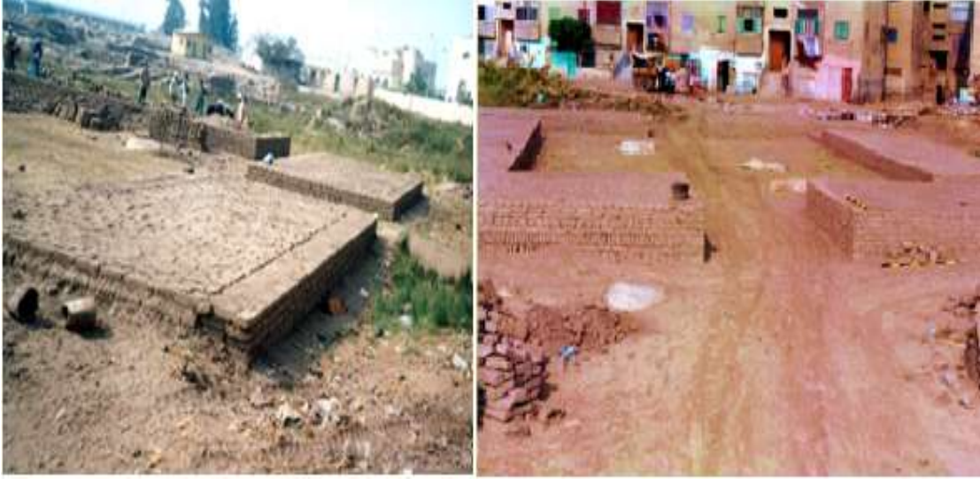
صورتان رقمى (13،14) توضحان اسلوب ترميم الصالة الأولى للقصر ( أثناء وبعد الترميم)
