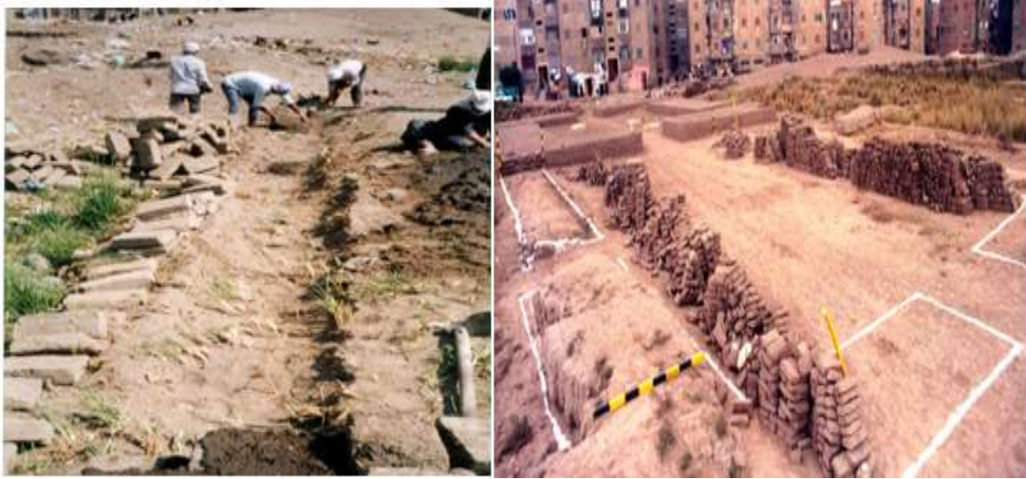
صورتان رقمى (11،12) توضحان اسلوب تحديد ابعاد الجدران بدقه باستخدام الخيط والجير والقوائم الخشبية
