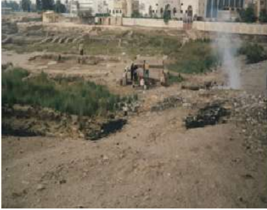
صوره رقم (2) توضح حالة المعبد قبل اعمال الترميم .
