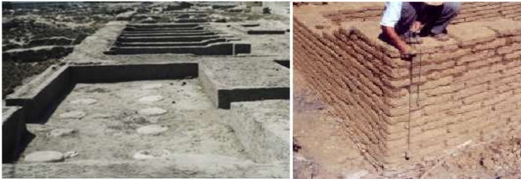
صورتان رقمى (29,30) توضح اسلوب وزن الحائط اثناء الترميم وبعض الحجرات الجانيبه بعد الترميم
